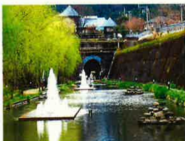
高森湧水トンネル
