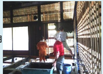
平成27年5月に実施した荒壁塗りの様子
